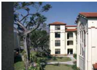
Escuela Bilingüe Ada Merritt
